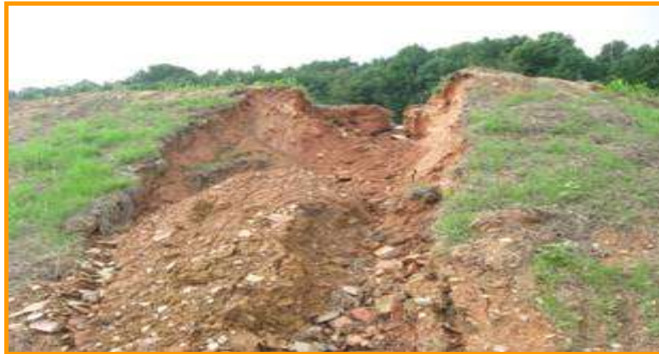
Shkëputja e truallit të sipërfaqës erozive
