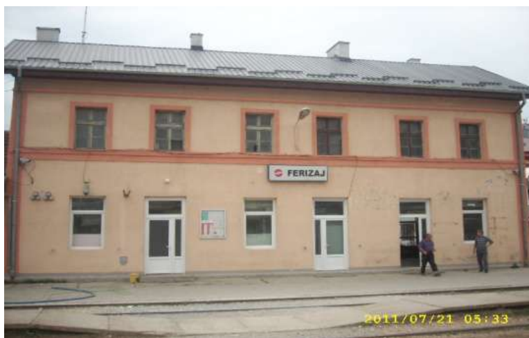
Fotografija 3 Izgled železničke stanice
