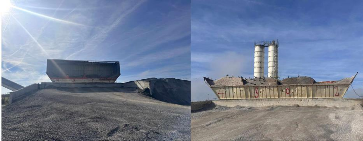
Figura 8. Bunkerët e Agregatit të dy bazave për prodhimin e betonit
