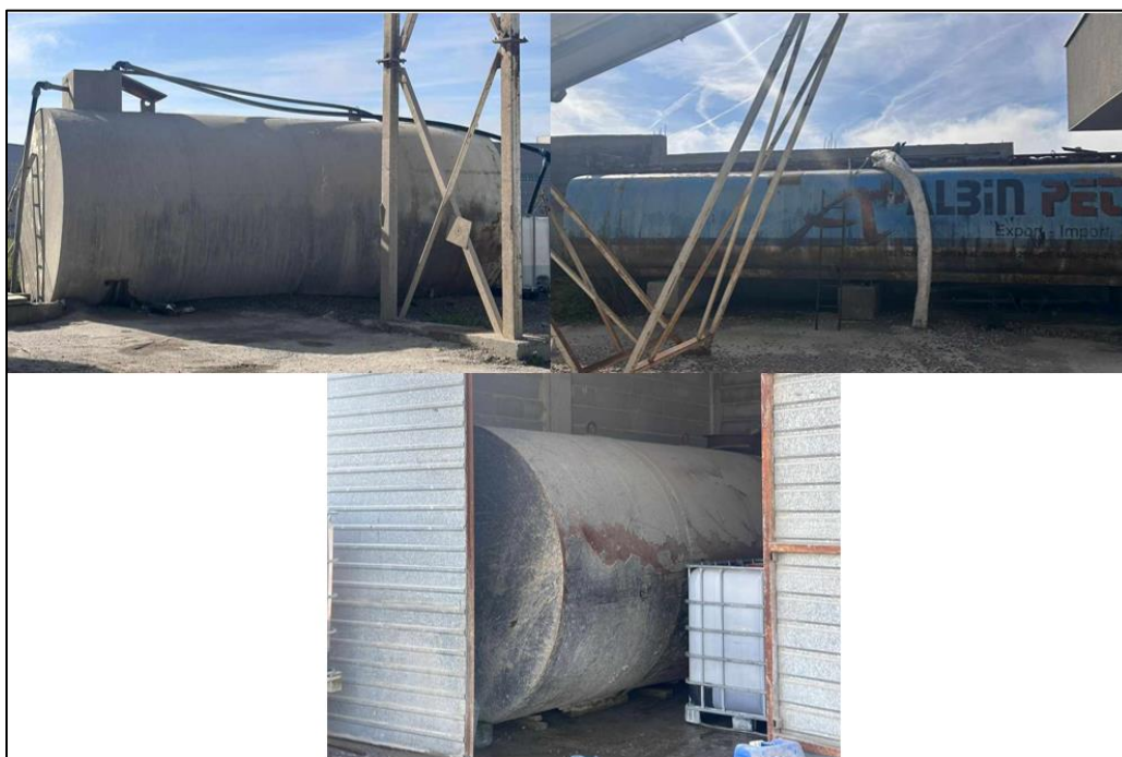
Figura 9. Rezervuarët e ujit 30000, 15000 dhe 5000 litra
