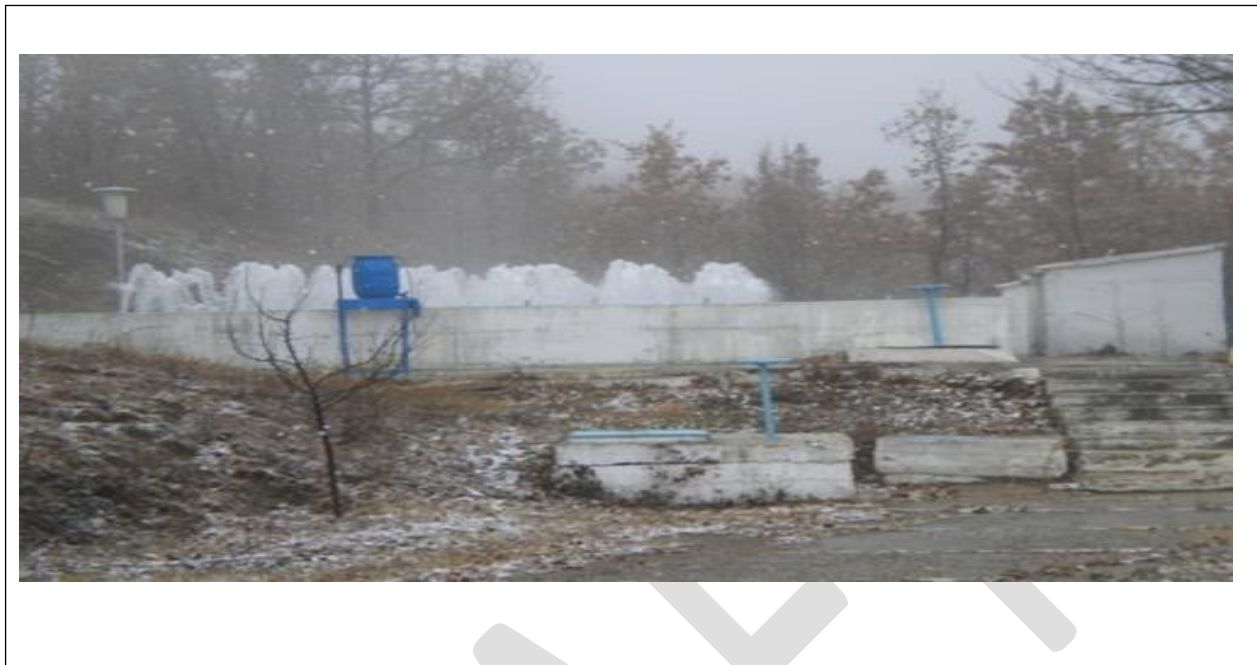
Fotografia 3. Ujësjellësi i Stacionit Rajonal në Graçanicë të Ujësjellësit të Prishtinës
