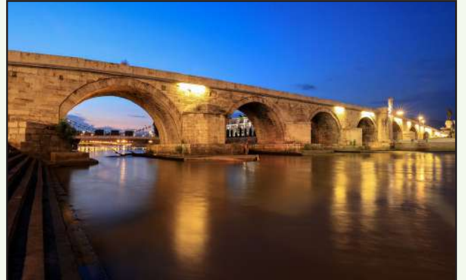
Osmanlı'dan Kalma Vardar Köprüsü
