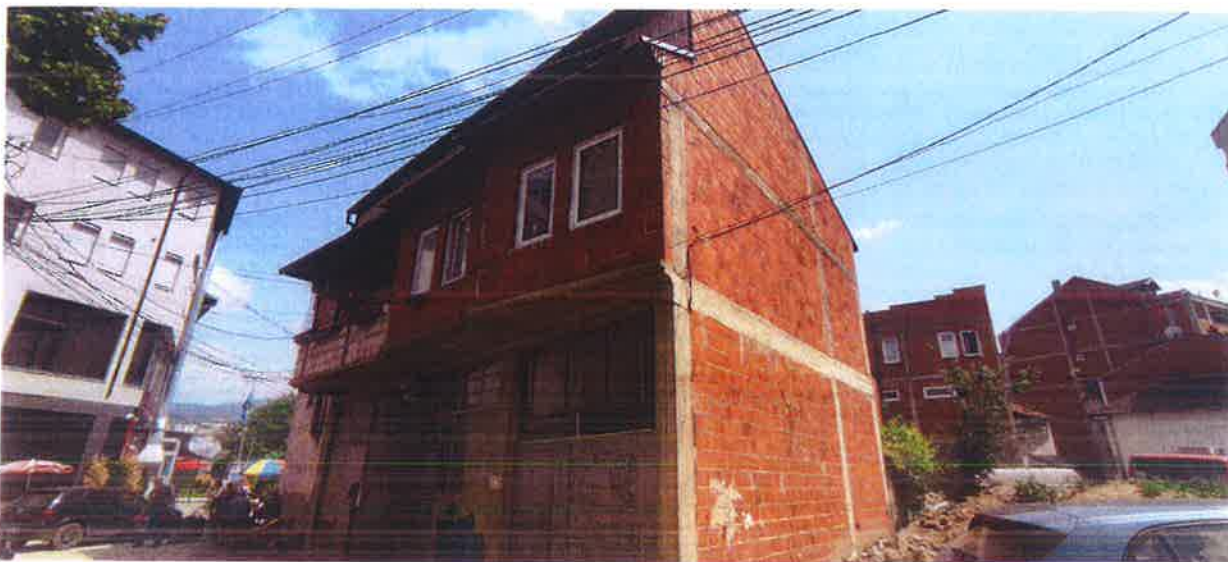
Foto 3. Foto e fasadës veri-perëndimore të objektit shtëpi banimi -maj 2024
