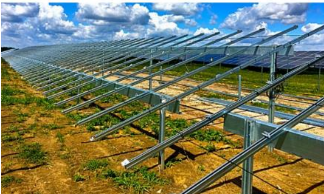
Fig.5 Pamje e Strukturave montuese te PV moduleve djellore
