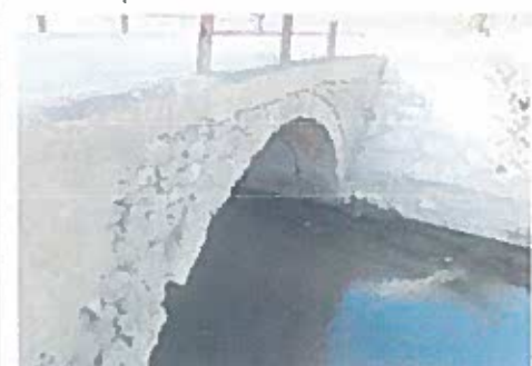
Guret e gdhendur dhe pllaka e betonit
