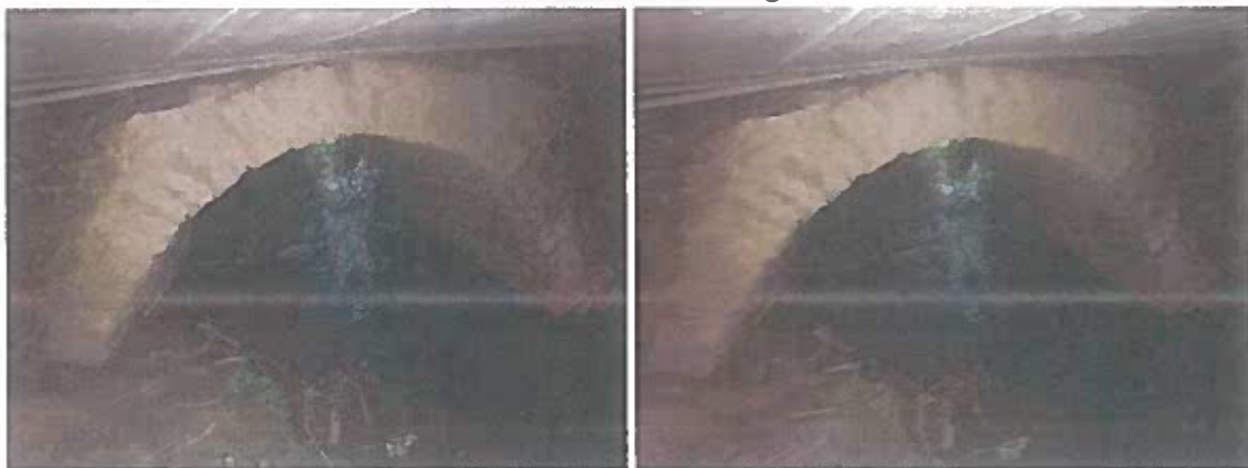
Pamjet e urës së gurit dhe betonimi i urës së re (2022).
