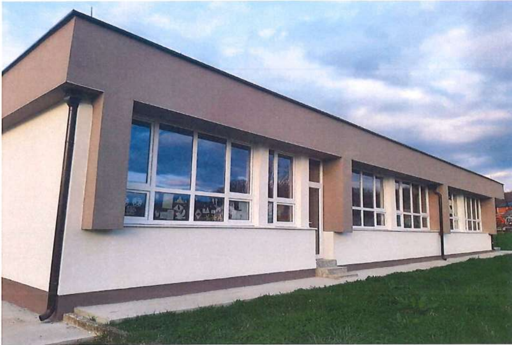
Projekti i efijencës së energjisë në objektin e Shfmu "Skënder Kastrati" në Gexhë
